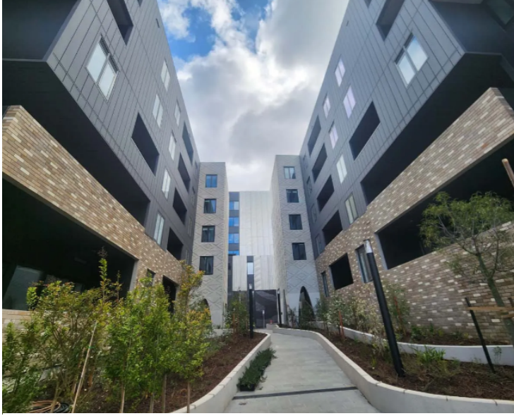
Abbotsford St North Melbourne'da inşa edilen yeni, enerji tasarruflu evler 2025'te açıldı.
